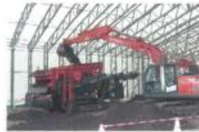
振動スクリーンによるふるい分け
