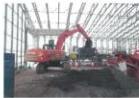
放射能濃度連続分別機への投入
