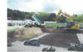
盛土材ダンプアップ
