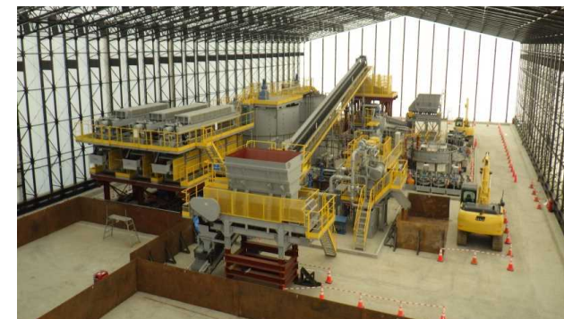
分級処理システム技術実証施設
