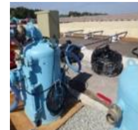
浸透水の集水設備の概観
