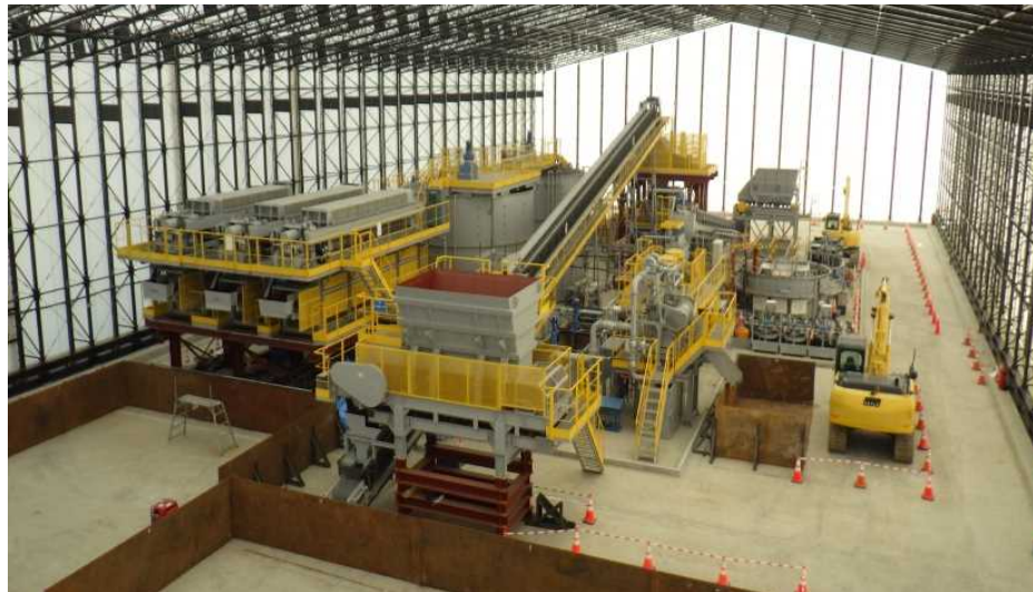
テント内全景 (11/29)
