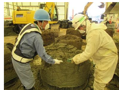
土質判定状況
