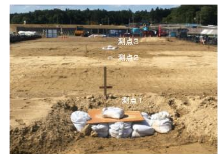
測点1~測点3 配置状況
