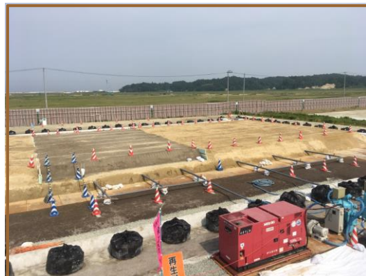
盛土施工状況(2層目)
