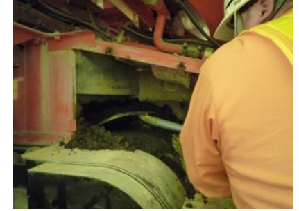
改質機土砂の排出作業状況
