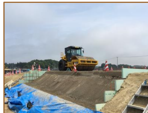
転圧状況(4層目)
