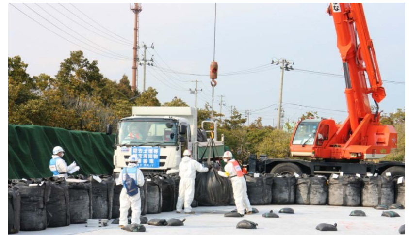
保管場への搬入・定置作業(大熊町内)
