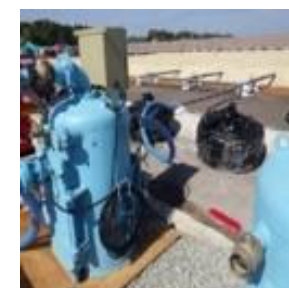
浸透水の集水設備の概観
