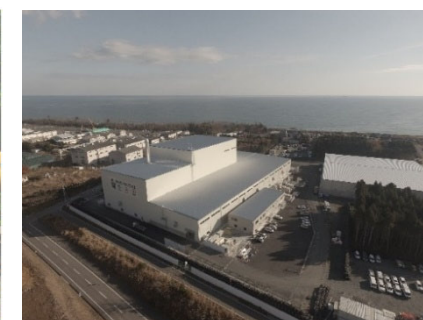
大熊町の仮設焼却施設
