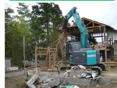
解体した被災家屋の基礎
