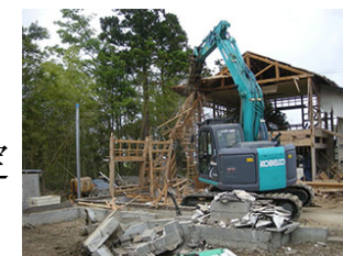
被災家屋等の解体
