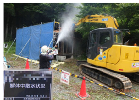
被災家屋等の解体の様子
