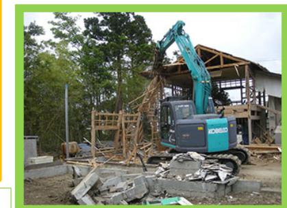
被災家屋等の解体
