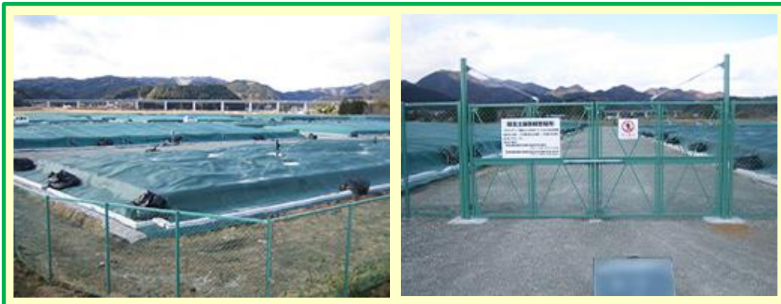
仮置場の設置の様子(写真は仮置場の一例) 出典:環境省ホームページ
