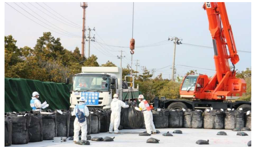
保管場への搬入・定置作業(大熊町内) 12
