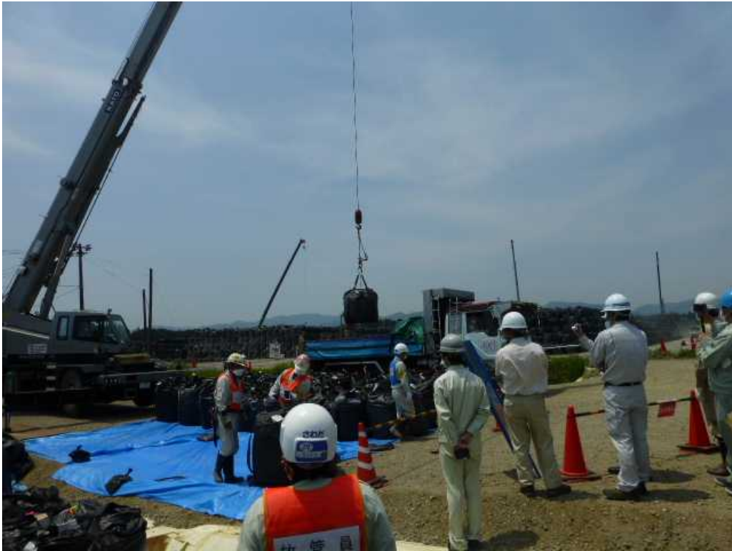
10tダンプへの積込み①
