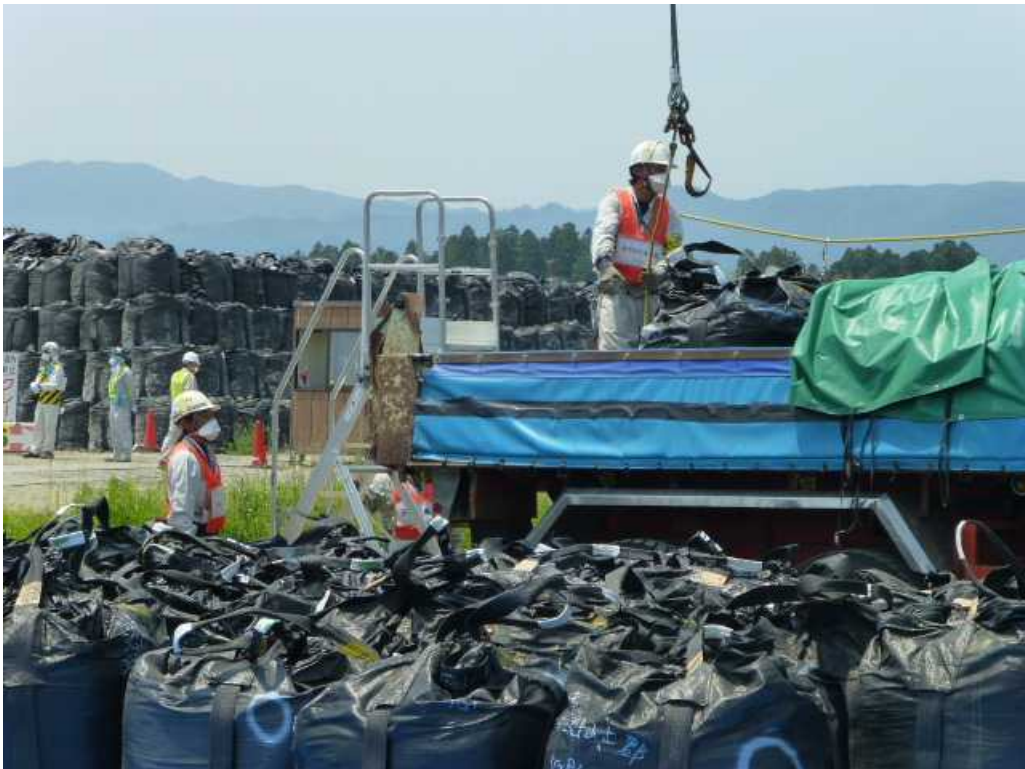
10tダンプへの積込み②
