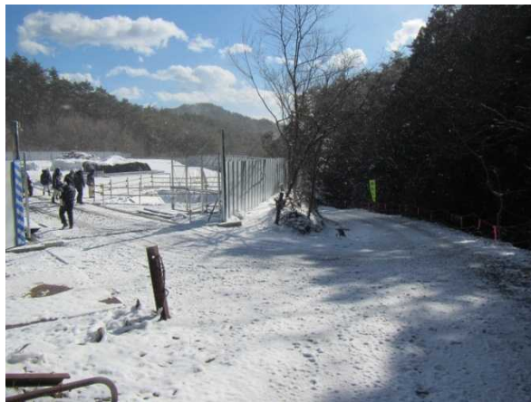
仮置場出入口付近
