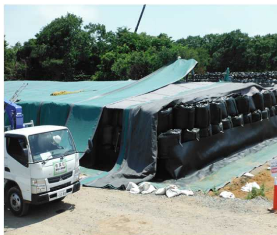
上部・側部をシートで被覆
