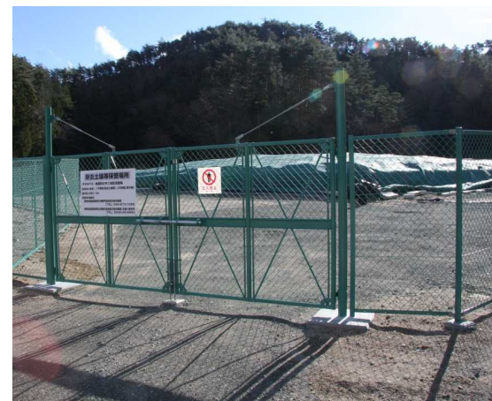
柵・看板・門扉の設置
