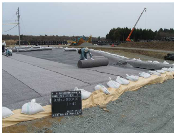
底部の遮水シート敷設
