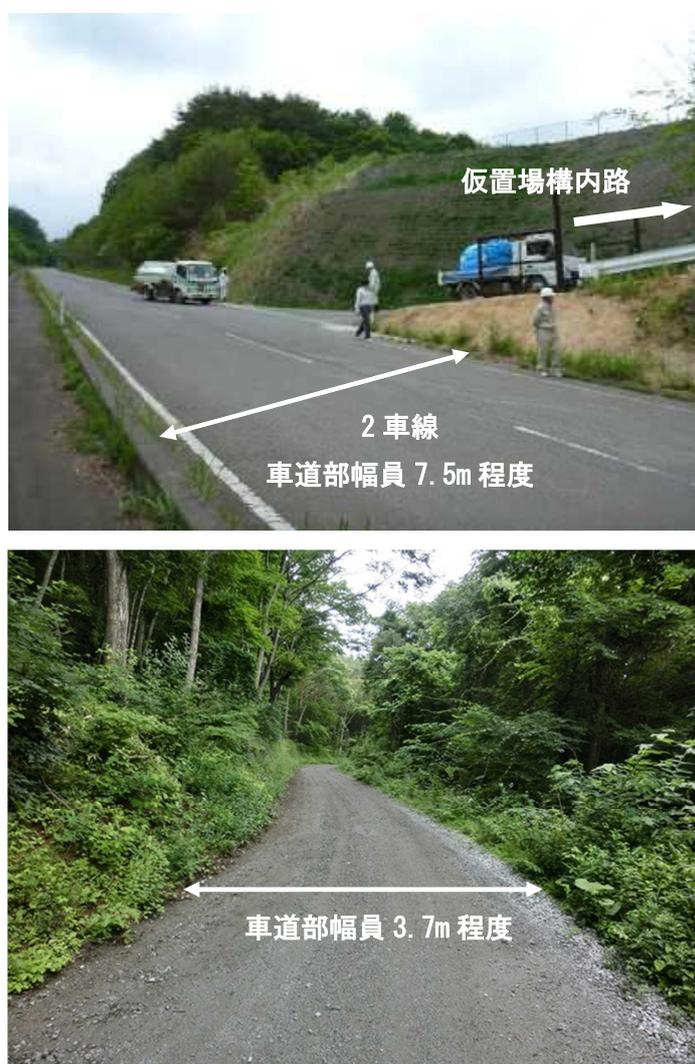
図12 仮置場へのアクセス道路の状況（例）
