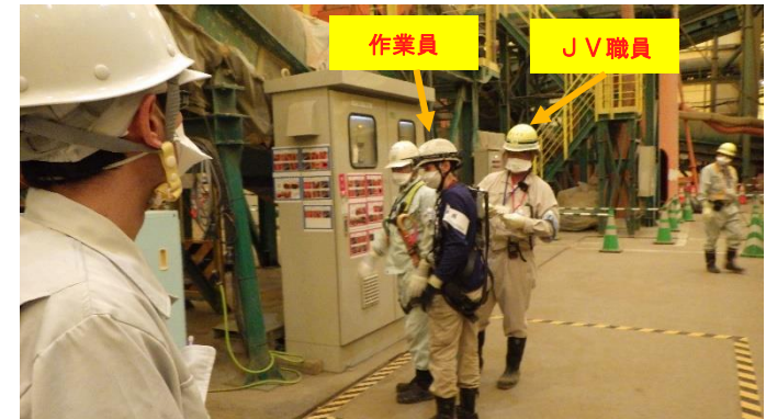
清掃作業の手順確認 （作業員による実演が行われている様子）
