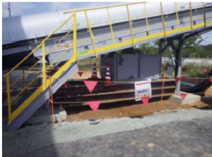
事故発生現場(対策実施後)
