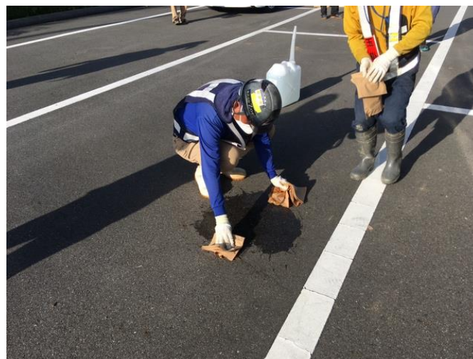
洗浄中 (キムタオルによる洗浄範囲の拭き取り →ビニール袋に入れて回収)
