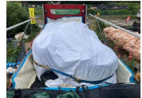
防水養生シートの固縛
