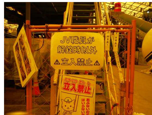
ガードフェンスの立入禁止措置
