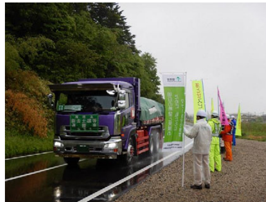
双葉町町道原田・目迫線確認
