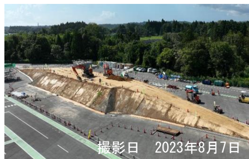
路床盛土工（覆土）
