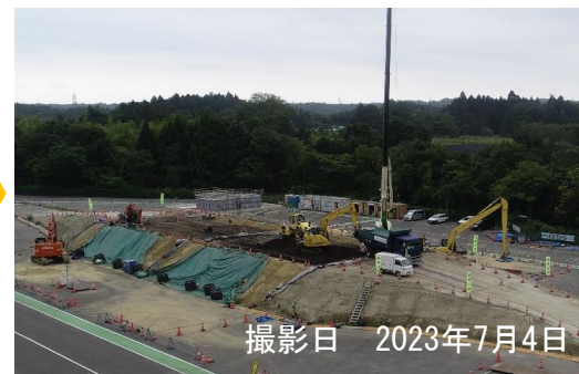
路体盛土工（路体11層目）
