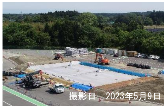
浸透水処理工（盛土底盤部）
