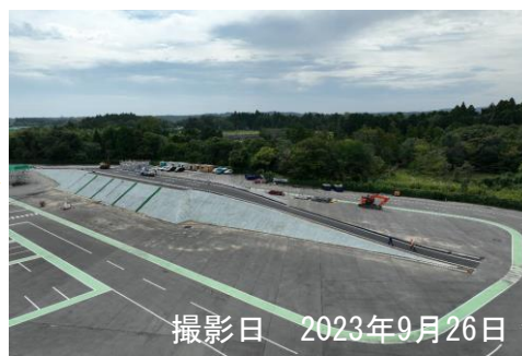
路面排水・舗装・法面工
