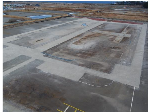
受入・分別施設(解体完了)
