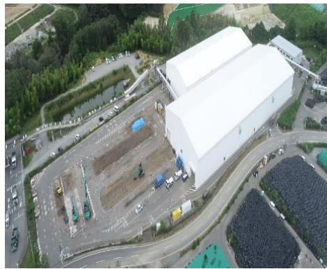
受入・分別施設(解体中)
