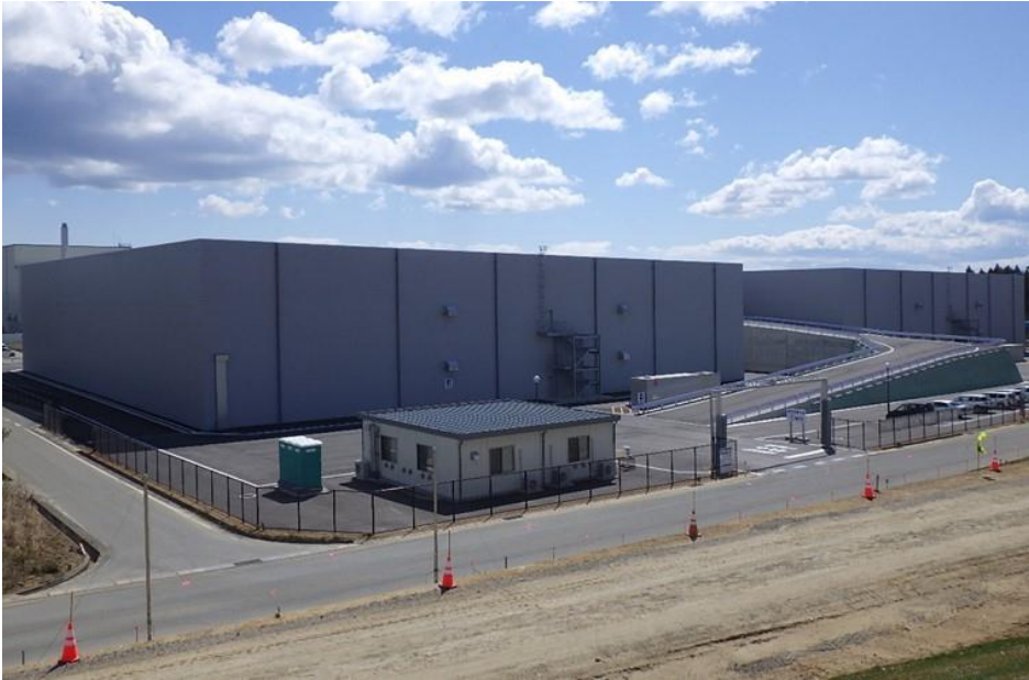
廃棄物貯蔵施設の外観
