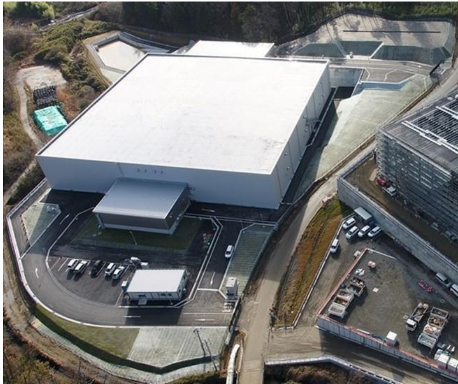
廃棄物貯蔵施設の外観
