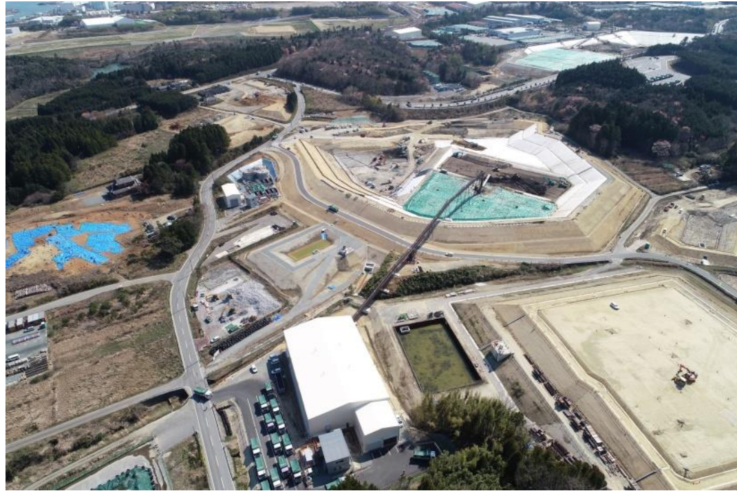
土壌貯蔵施設(西側)
