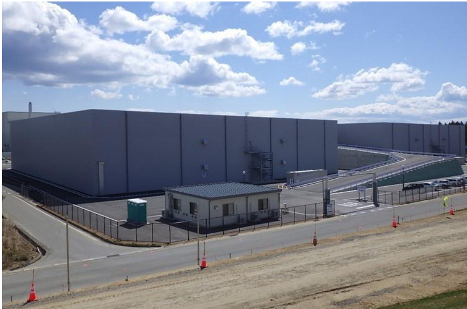
廃棄物貯蔵施設の外観
