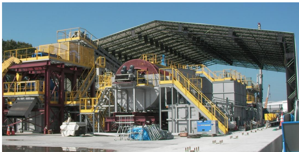
【工事現状 (2018年10月26日撮影)】
