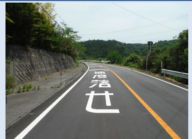
改良工事後の道路の様子(国道288号線)
