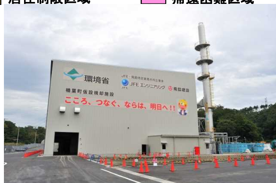
楢葉町の仮設焼却施設 (平成28年10月)
