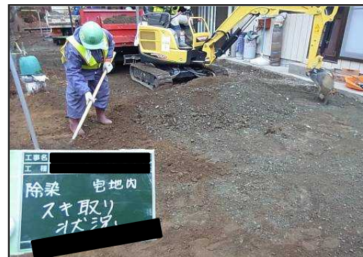
庭碎石の除去・被覆
