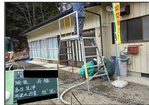
縦樋の高圧水洗浄
