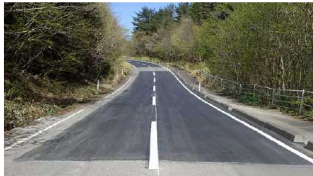
道路補修後の状況
