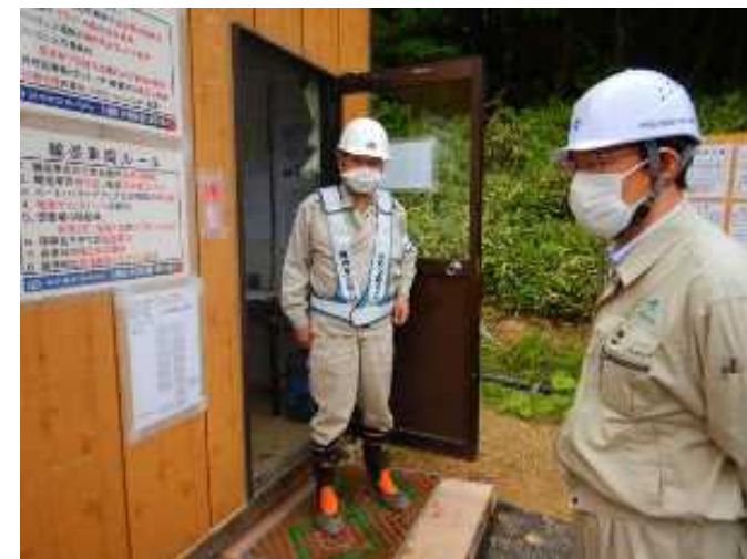
発注者安全点検
