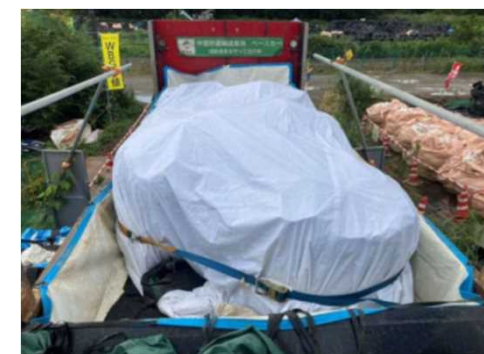
防水養生シートの固縛
