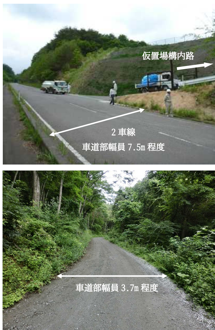
図 1 2 仮置場へのアクセス道路の状況（例）
