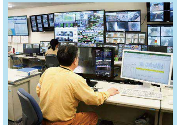
⑤ 集中監視室
