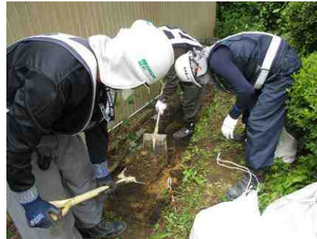
2. 線量に応じて土壌剥ぎ取り
