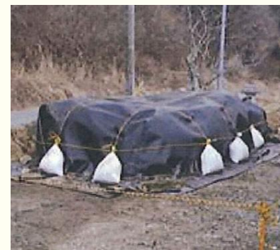
遮水シート養生
