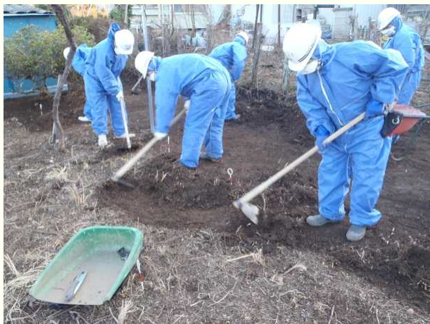
家屋除染(表土削り取り)
