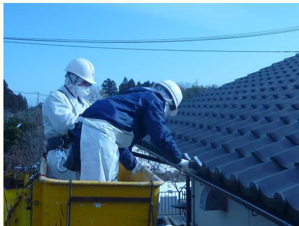
家屋除染(軒樋)
