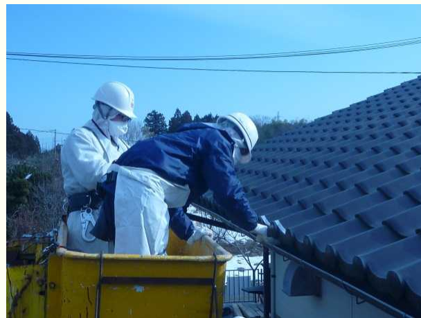
家屋除染(軒樋)
