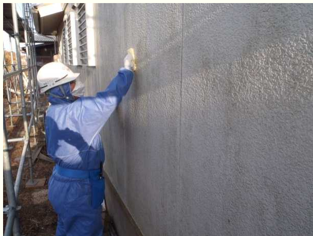
家屋除染(壁拭き取り)
