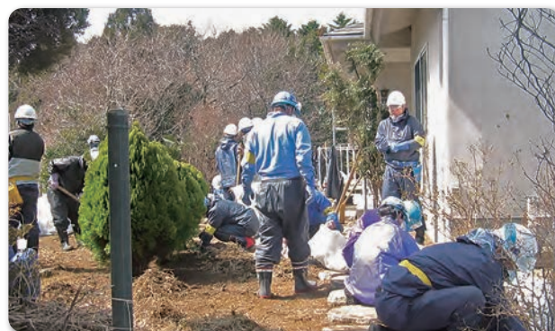
住宅の庭の除染作業の様子
