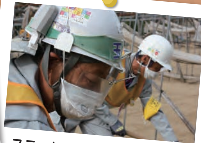
ステッカーをヘルメットに貼り 除染作業に励む作業員さん
