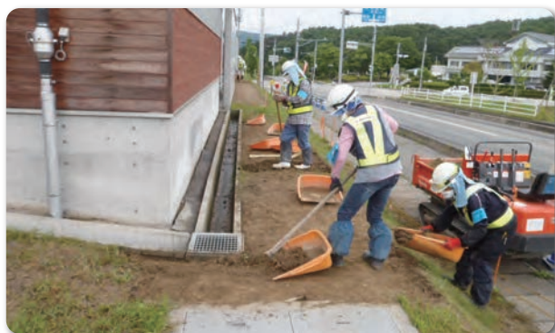
建物周辺の表土削り取りをする様子
